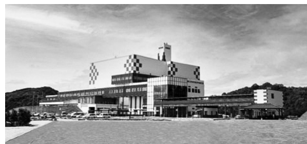
写真1 施設全景(カタログより)
