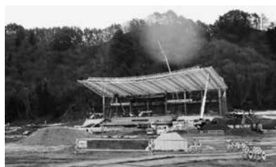
建設中のスタジアム
