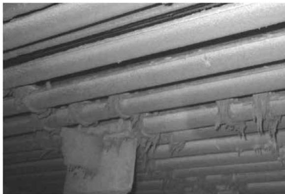
図6 圧力波クリーニング実施時
