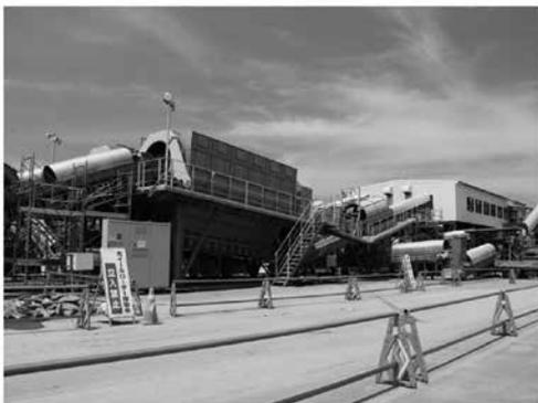
(e) 仮設の破碎・選別処理施設
