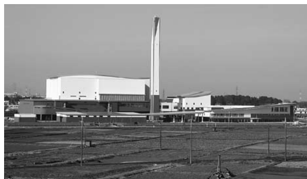
川越市資源化センター熱回収施設全景
