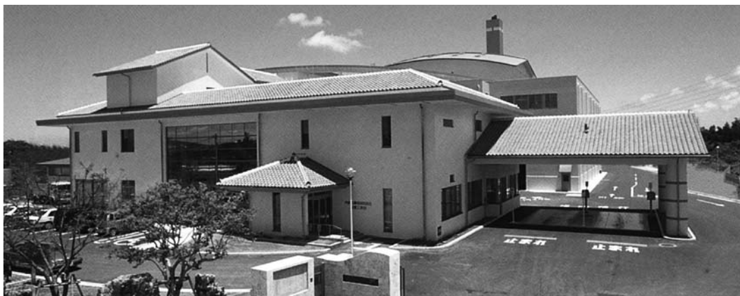
沖縄県中部北環境施設組合 美島環境クリーンセンター
