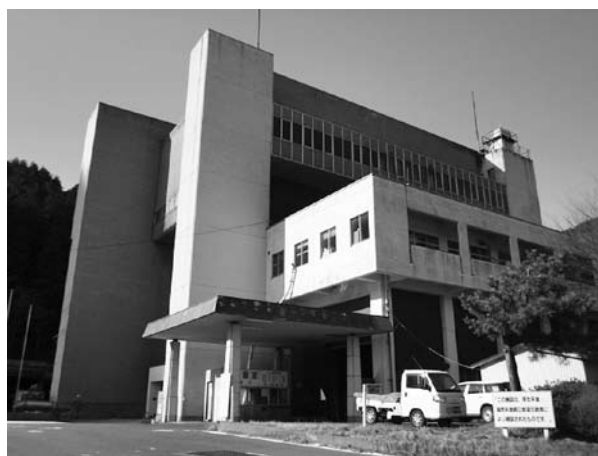
写真1 釜石市清掃工場(旧炉)外観
