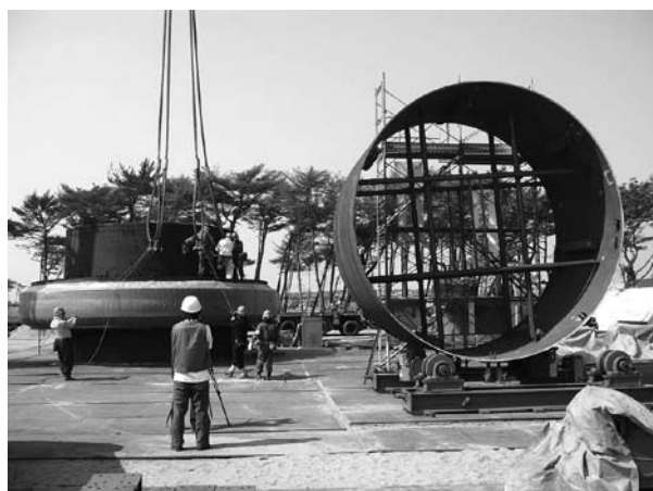
写真 1 荷卸・仮置中のロータリーキルン
