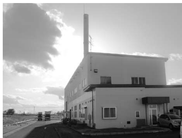
写真 6 本復旧完了時施設外観
