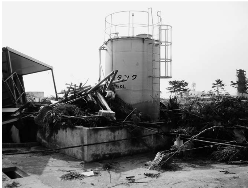
写真2 津波で流されてきた瓦礫
