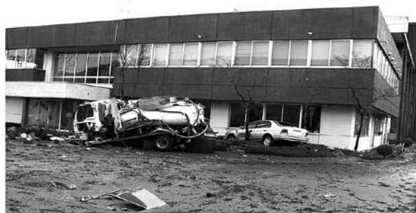
写真 1 被災翌日の施設外観
