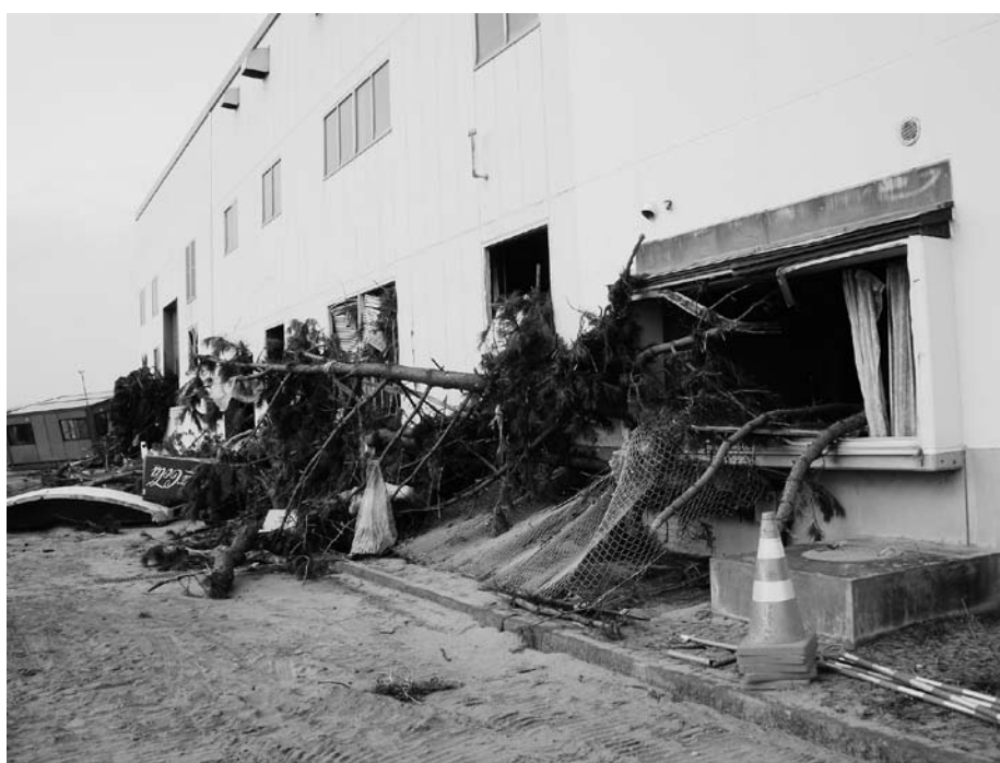
写真1 津波で一部損壊した施設外観
