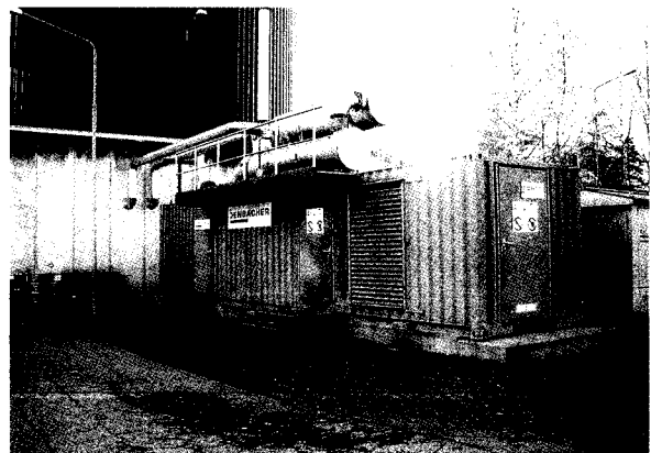
写真-2 バイオガス発電プラント
