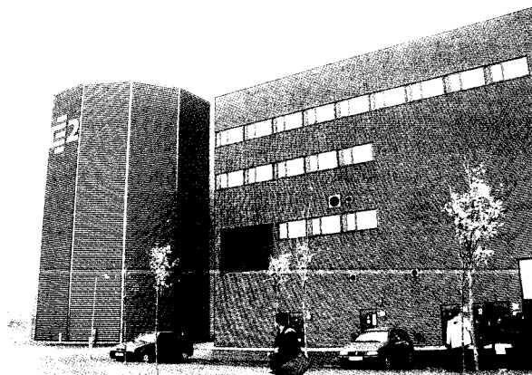
写真4 温水タンク (写真左)
