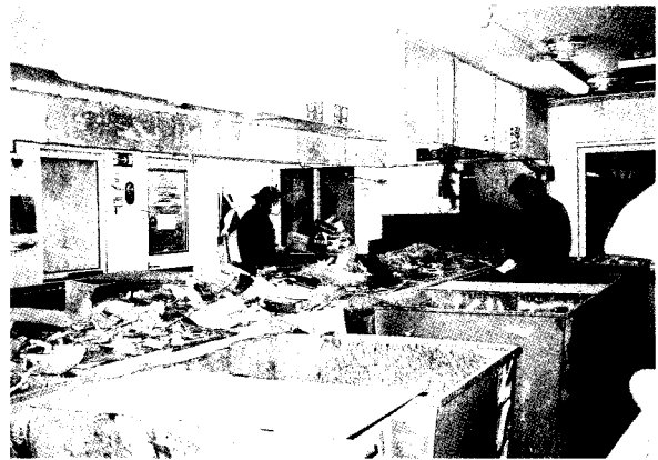
写真2 手選別風景（建設廃材処理施設）
