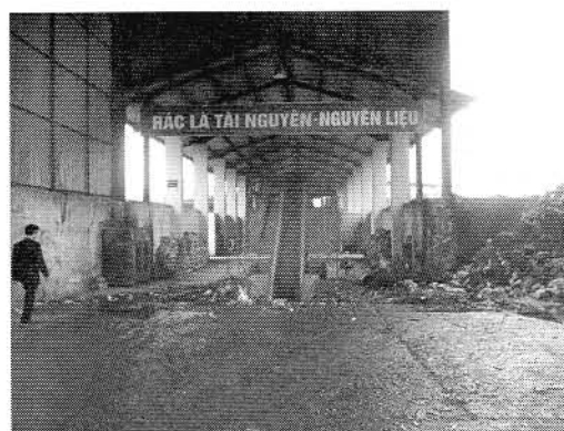
受入れヤード
