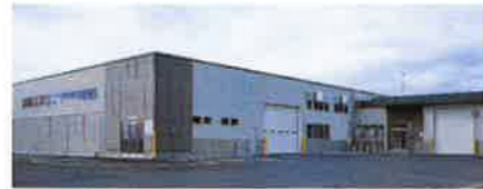
Esashi-cho Clean / Esashi Recycling Center
